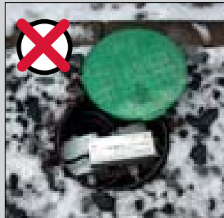
Netzteil ungeschützt im Bodenschacht Power supply unprotected inside the ground shaft Source d'alimentation sans protection dans un puits au sol
