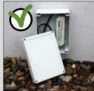
Korrekte Installation im Elektrogehäuse Correct installation inside the electrical cabinet Installation correcte dans le carter électronique
